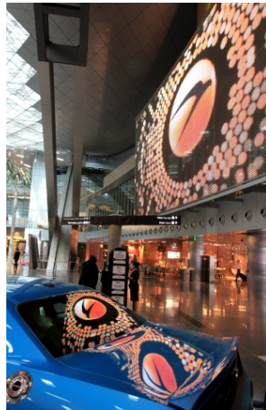
Bild 1 + 2: Vier großformatige MEDIAMESH®-Screens aus Edelstahlgewebe mit integrierten LED-Profilen von GKD wurden in der Haupthalle des Duty Free Bereiches und in Halle C des Hauptterminals installiert.
