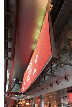
Bild 3 + 4: Um den filigranen Gesamteindruck der MEDIAMESH®-Screens von GKD zu erhalten, wurden die Gewebepaneele mit der patentierten Klebtechnik Fusiomesh NG an der Rahmenkonstruktion befestigt.
