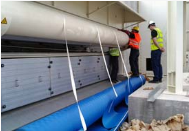
Bild 5: Die GKD Einziehhilfe vereinfacht die Installation des Trocknerbandes.
