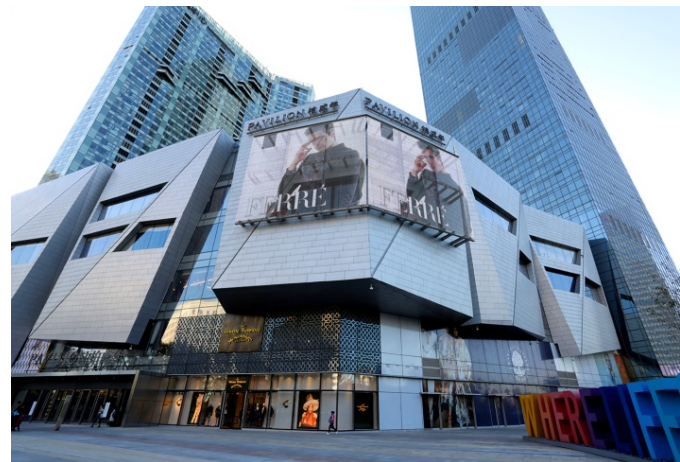
Bild 4: Die Transparenz der gewebten Struktur gewährleistet, dass die hinter der Medienfassade liegende Räume mit Tageslicht versorgt werden.
