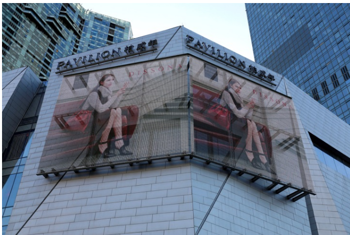
Bild 3: Die beiden 10,35 Meter hohen und bis zu 24 Meter breiten transparenten Displays von GKD verlaufen an zwei Eingängen jeweils über Eck und lösen dadurch – je nach Bespielung – den 90°-Winkel optisch auf.
