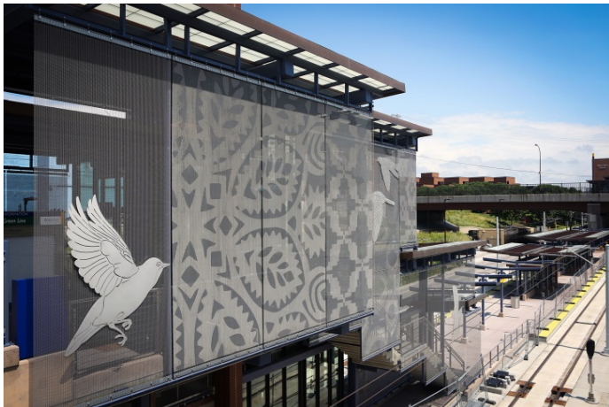
Bild 1: AECOM Architekten entwarfen für die West Bank Station einen zweigeschossigen Bahnhof. Zum Schutz gegen die Sonne wurde er mit Metallgewebe von GKD verkleidet.
