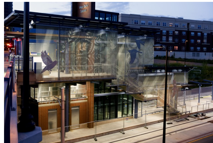
Bild 5: Außen angebrachte Strahler setzen gezielte Lichteffekte, die sich je nach Position des Betrachters verändern und so das transparente Gewebe unvermutet opak wirken lassen.
