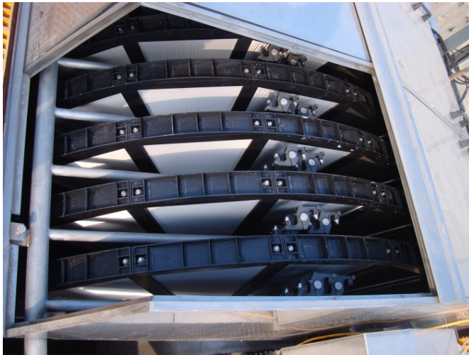
Bild 1: Eingebaute Filtersegmente von GKD.
