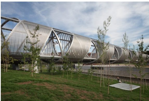
Bild 7: GKD-Edelstahlgewebe vom Type Escale umschlingt die Fußgängerbrücke Pasarela del Arganzuela in Madrid auf voller Länge und verwandelt sie in eine schimmernde Helix.
