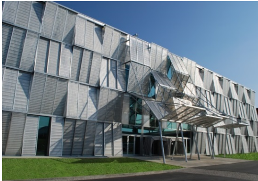
Bild 9: Seine Einzigartigkeit verdankt der Pôle de bioingénierie der Ecole Polytechnique Fédérale de Lausanne (EPFL) einer dreidimensionalen Zickzack-Fassade aus 630 horizontal verschiebbaren Sonnenschutzelementen aus GKD-Metallgewebe.
