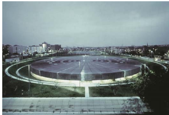
Bild 3: Eine begehbare Dachverkleidung aus GKD-Metallgewebe bekleidet das obere Drittel der Rad- und Schwimmsporthalle in Berlin von Dominique Perrault.
