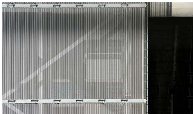
Bild 4: Die metallisch glänzende Hülle besteht aus einer Sonderanfertigung des GKD-Edelstahlschwarzspiralgewebes vom Typ Escalé 10,5 x 1,2.
