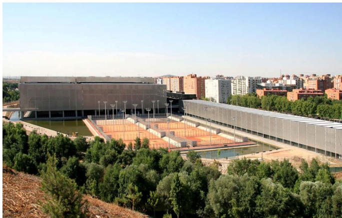
Bild 5: Markantes Wahrzeichen des Parque del Manzanares ist das Centro Deportivo Multifuncional del Manzanares von Dominique Perrault.
