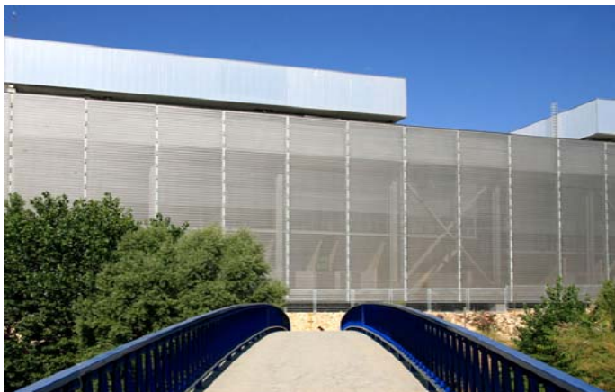
Bild 1: Insgesamt 86 Paneele des Escalé-Gewebes, jede ca. 23 x 7 Meter groß, wurden zur Verkleidung des Gebäudekomplexes verwendet.
