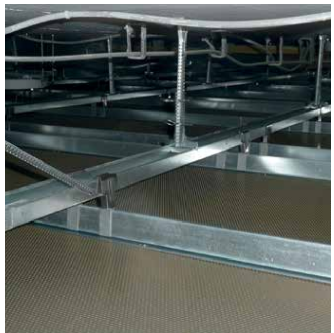
Rückseitig angenieteter L-Winkel zur Befestigung im Klemmprofil. Gewebe: CMP-Alu 6010 (9)
